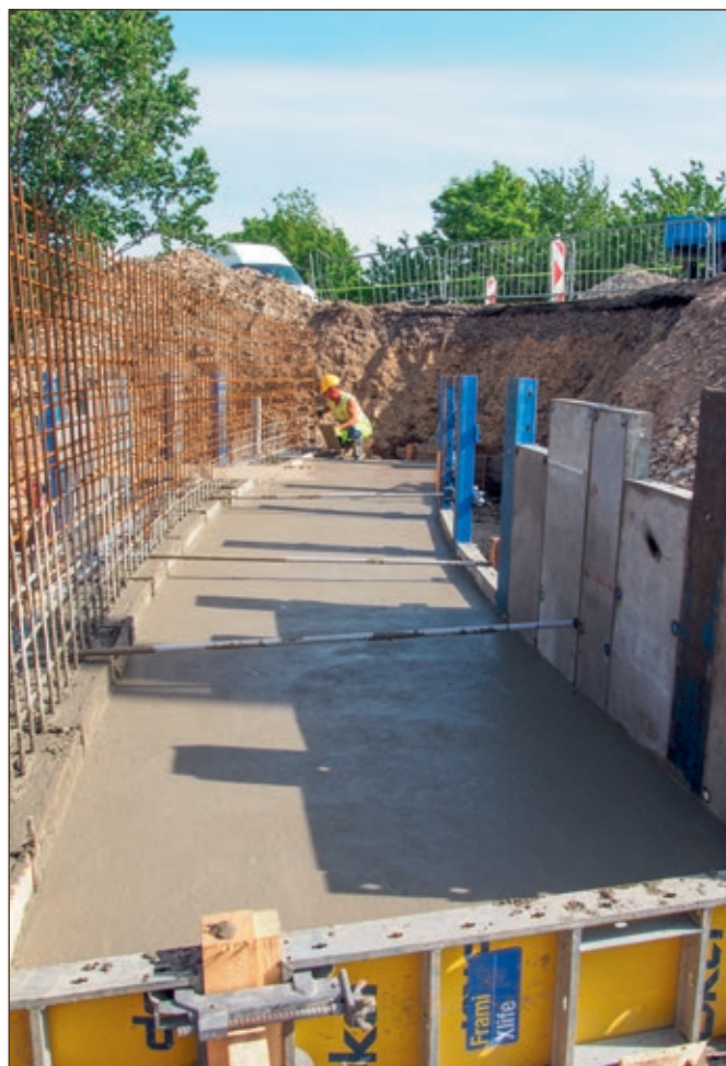
Zabetonovaný základ opěrné zdi je ukázkou dokonale odvedené práce
