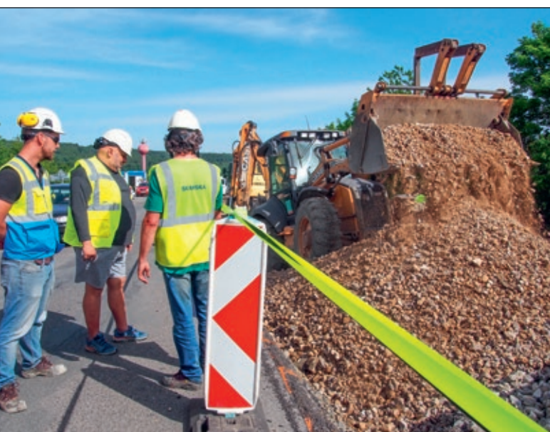
Nepotřebné podkladové kamenivo se odváží ze stavby pryč
