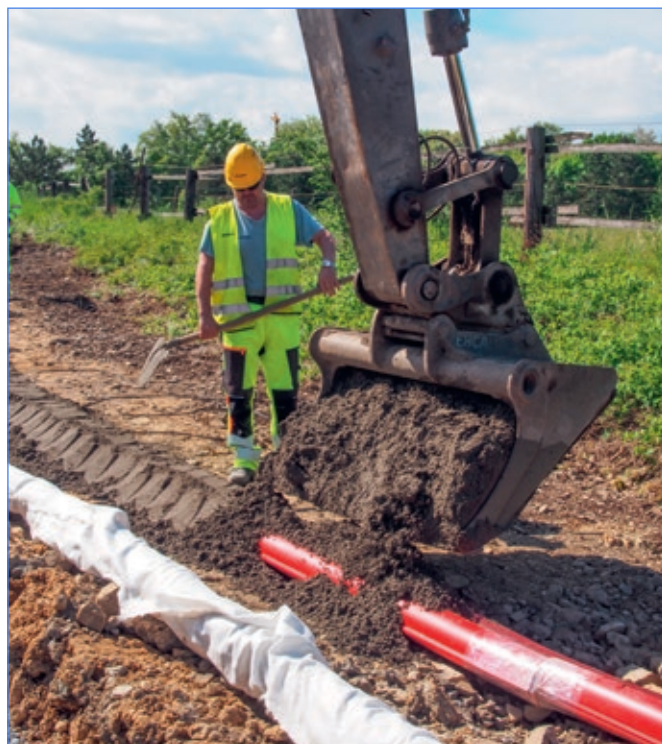
Obetonování CETIN kabelu
